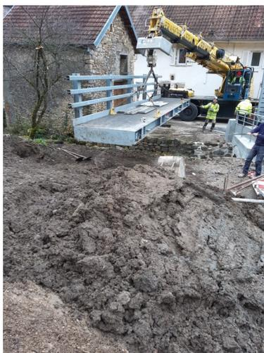
Le pont en « kit » fut installé juste à côté de celui à rénover.
